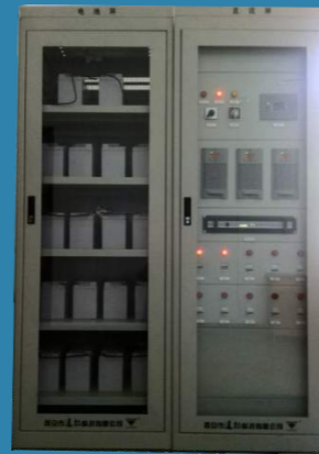
图5-1 GZDW微机高频开关直流电源
