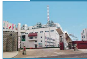
辽宁铁法煤业集团热电厂
